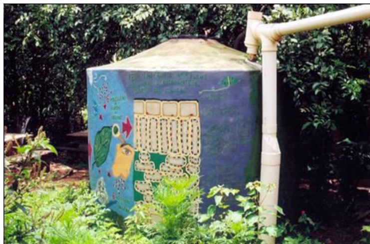
Figura 37: Cisterna de Ferro-Cimento (foto: Gustavo Martins).
